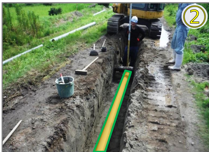
仮設管きょの設置
