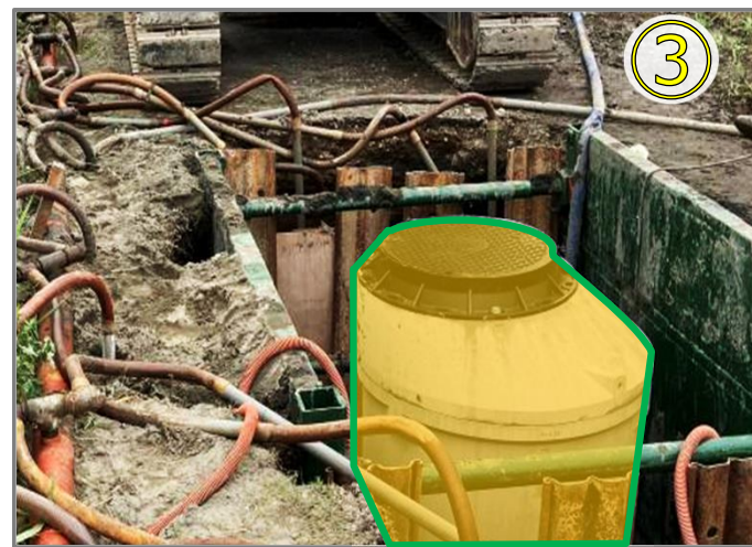
仮設ポンプの設置
